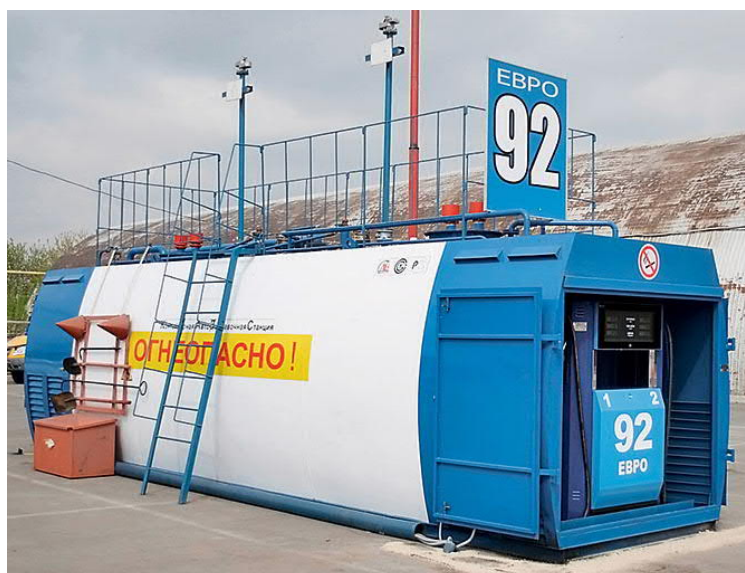
Рис. 3. Внешний вид контейнерной АЗС
