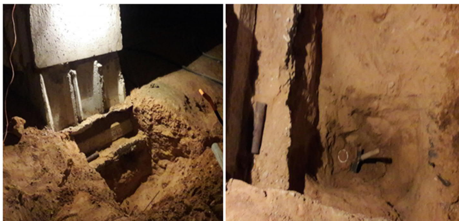
Рис. 2. Вид процесса отбора проб грунта из основания под фундаментом
