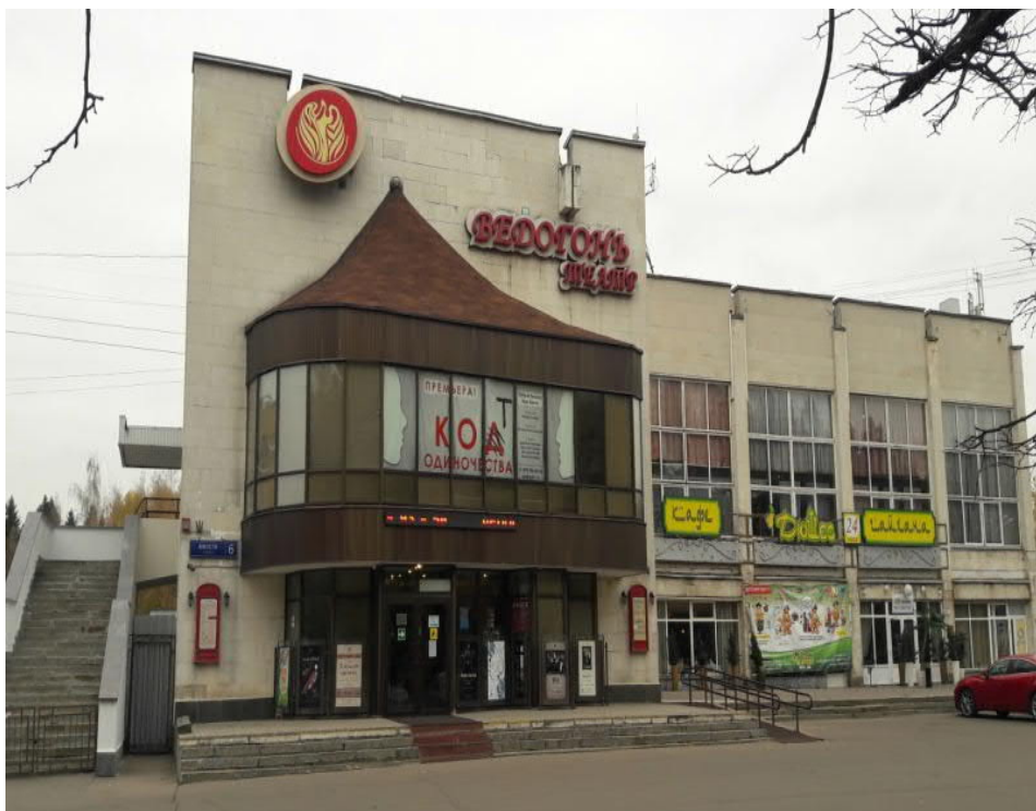
Рис. 1. Общий вид объекта
